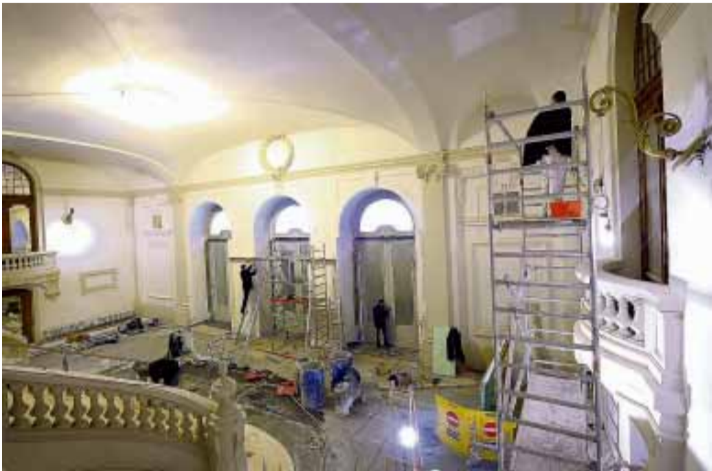
Derzeit werden die Vordertüren eingebaut
